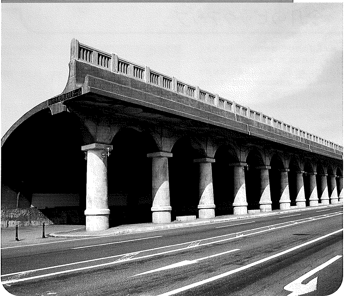
北海道遺産：稚内市「稚内港北防波堤ドーム」
