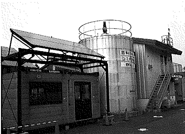
バイオガスプラント
