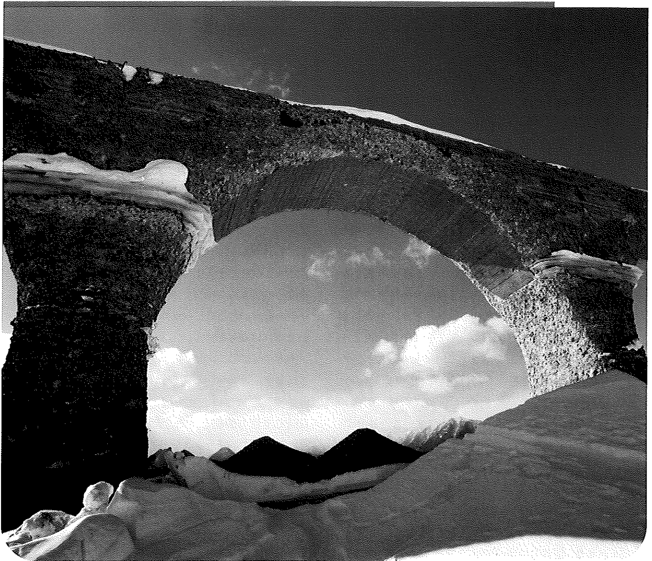
北海道遺産：上士幌町「旧国鉄士幌線コンクリートアーチ橋梁群」
